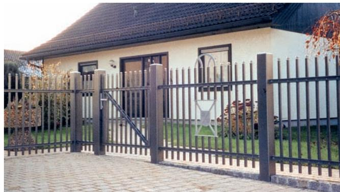
Stabzaun mit pulverbeschichteter Oberfläche nach RAL
