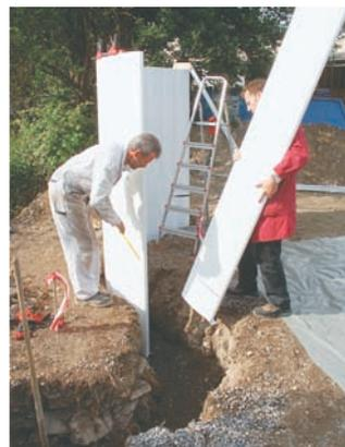
**Montagehinweis:** Der Graben für die Palisadenprofile muss 35 bis 40 cm breit und frostsicher sein. Bei bindigen Böden ist eine Drainage vorzusehen. In jedem Falle muss eine 10 bis 15 cm Rollierung eingebracht werden. Darin werden die Profile eingestellt und in der gewünschten Kontur ausgerichtet. Feuchtigkeitsanfall innerhalb des Palisadenprofils wird durch das direkte Einstellen in die Rollierung abgeführt.
